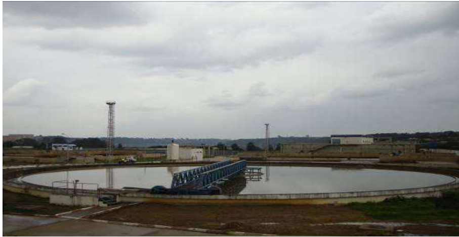
Figure 8 : Décanteur primaire. (Photo originale)
