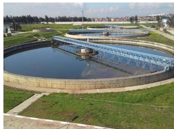
Figure 10 : Les décanteurs secondaires (Photo originale)
