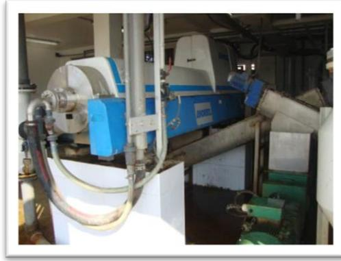
**Fig.16 Centrifugeuse de déshydratation.**
