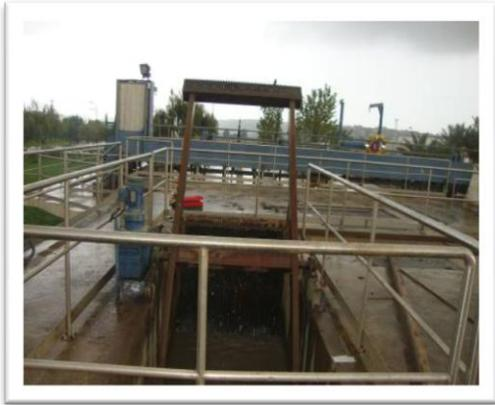
**Fig.05 Dégrilleur automatique.**
