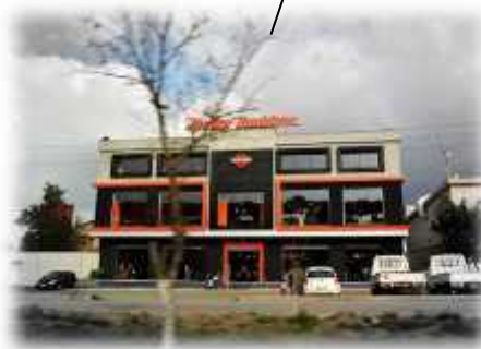
Figure: Zone industrielle Oueled Aich en bon état
