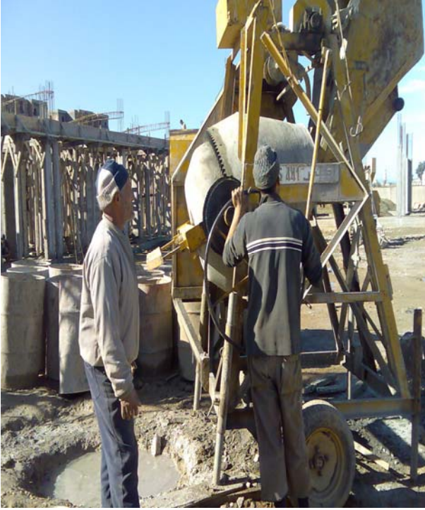
Malaxage des composants du béton
