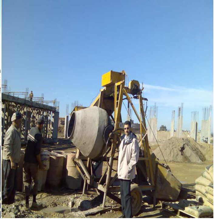
Malaxage des composants du béton
