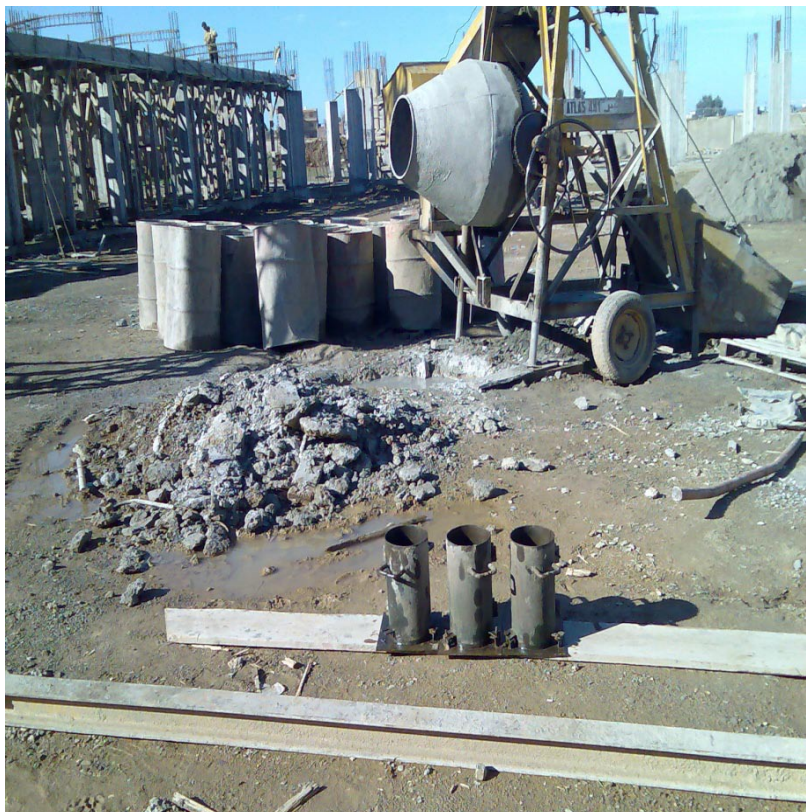
Figure 4.1 : Le malaxage des constituants du béton avant le coulage .
