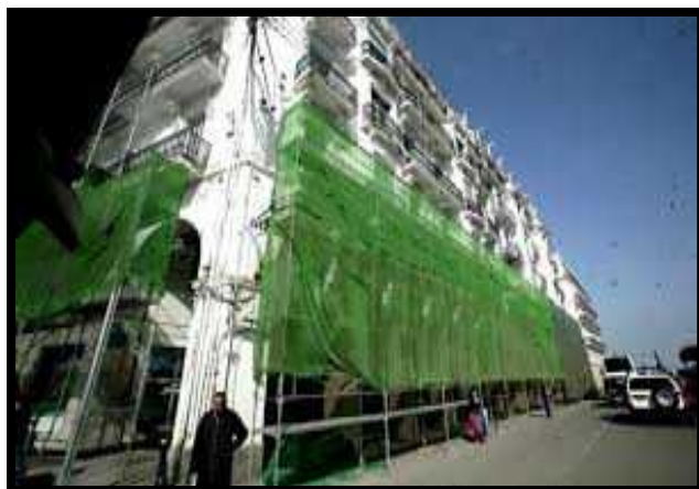
Réhabilitation du cadre bâti. Source : ben m'Hidi.jpg
