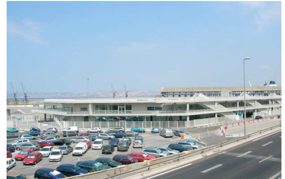
Figure 2.25 : La nouvelle gare maritime
