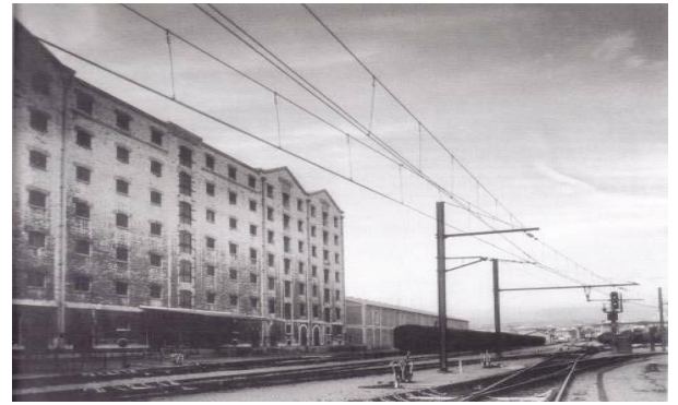
Figure 2.38 : Les docks et la gare de la Joliette
