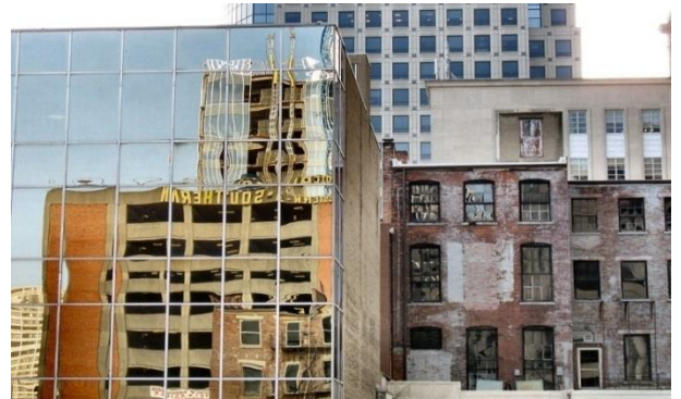
Figure 2.2 : Exemple de rénovation urbaine
