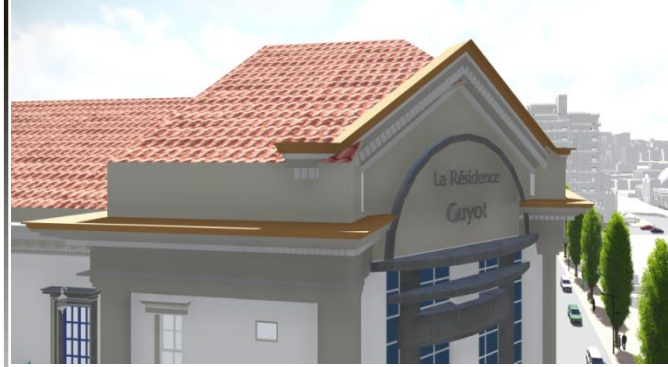
Toiture en tuile
