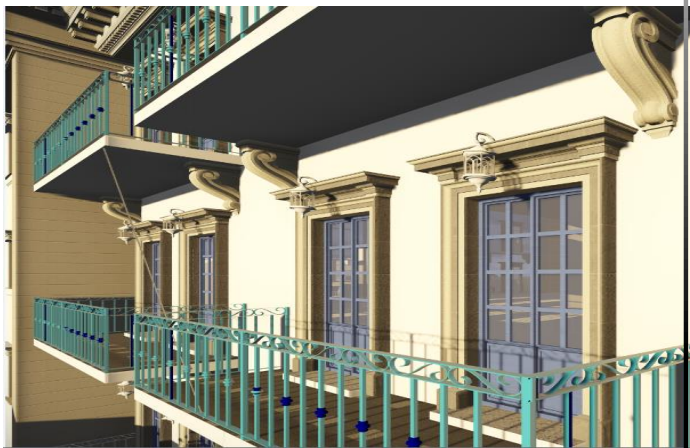
Garde corps en fer fourgué
