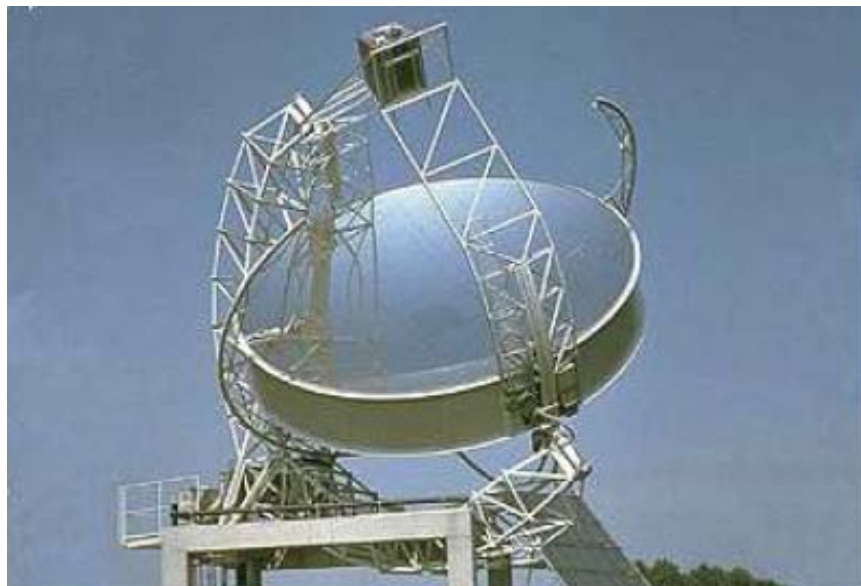
Figure 1.25: Le système DISTAL I de 9 kWe par SBP installé en Allemagne
