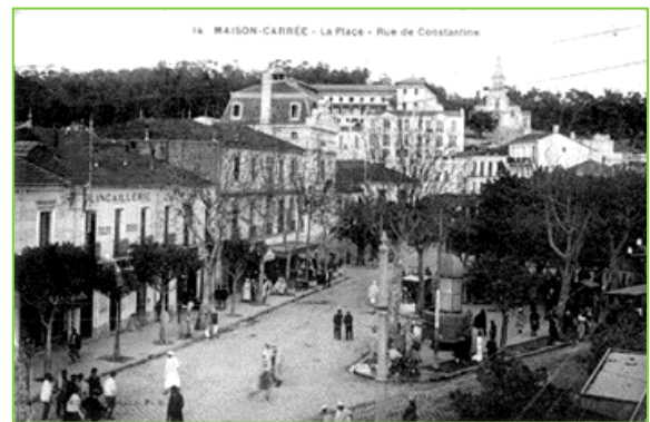
Figure III. 6 : Maison carrée. La place :rue de Constantine .Source : http://www-article-el-harrach-ex-maison-carree/
