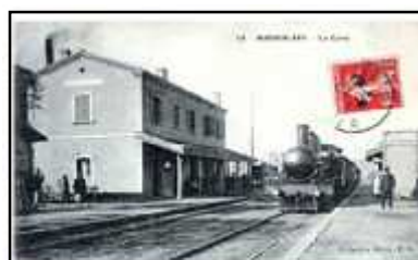
● La gare ferroviaire
