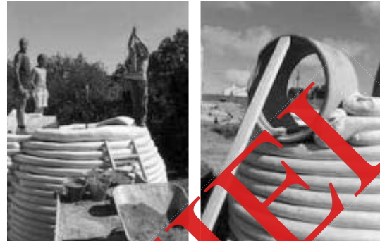
Figure 3, 4, 5, 6, 7, 8 : procédé de construction en super adobe.
