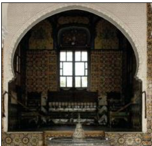
Figure III. 26 L'arc outrepassé brisé au Bardo
