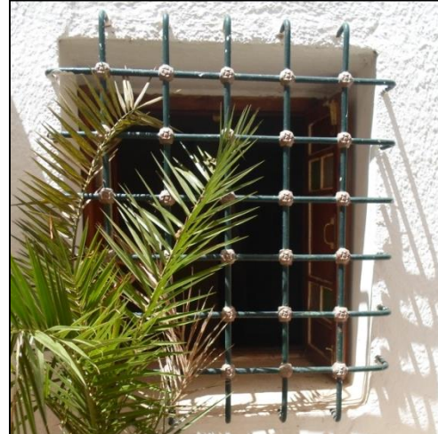
Figure III. 25 Fenêtre quadrangulaire à Miliana
