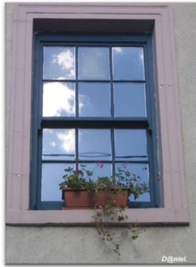
Figure II. 12 Fenêtre à guillotine
