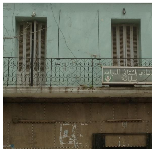
Figure III. 31 Un mur nu rue Emir Abd El Kader, Miliana
