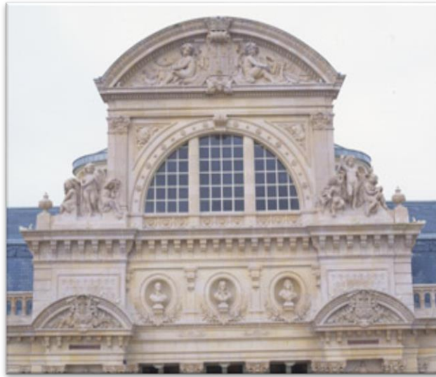
Figure II. 14 Fenêtre dioclétienne
