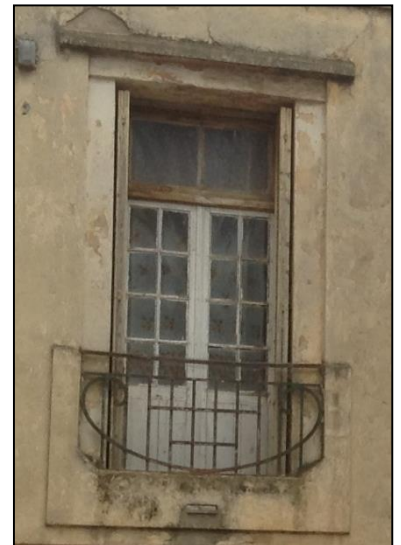
Figure III. 20 Fenêtre avec imposte et seize carreaux de verre
