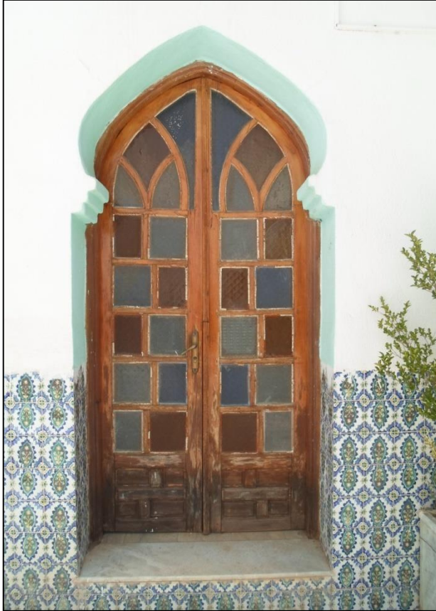
Figure III. 9 Fenêtre avec arc outrepassé brisé
