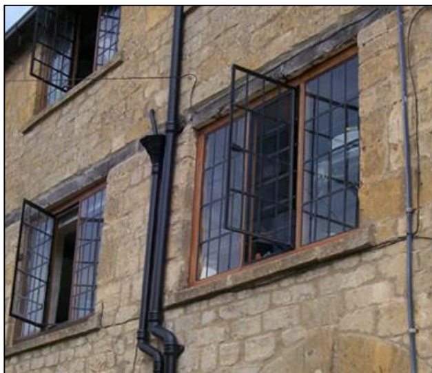
Figure II. 9 Fenêtre à battants
