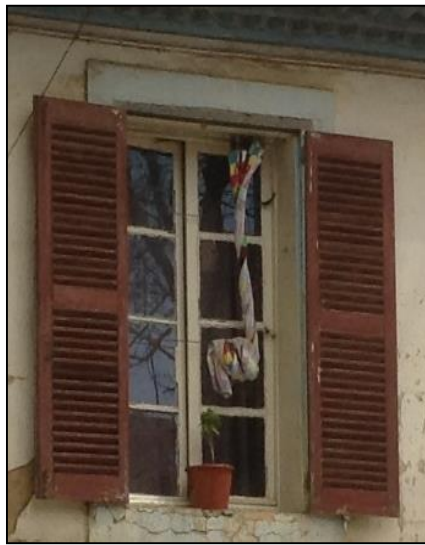
Figure III. 19 Fenêtre à battants à huit carreaux de verre
