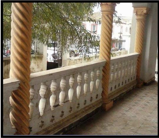
**Fig22. Garde corps en plâtre**
