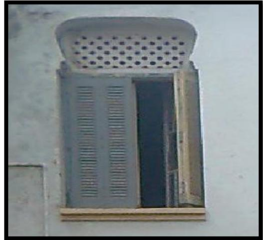
**Fig23.moucharabieh en plâtre dans la fenêtre**
