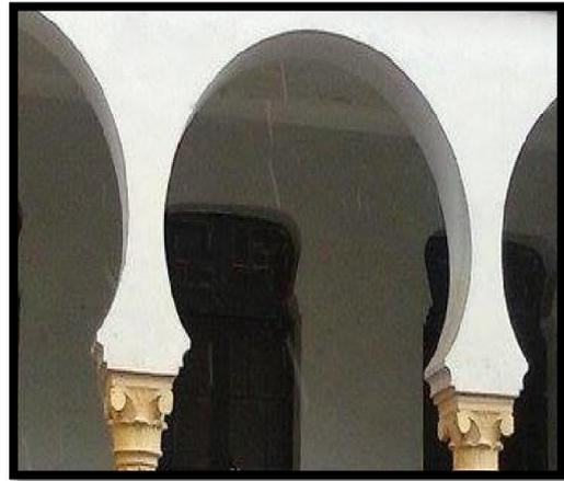
**Fig19.arc outrepassé en brique plein**
