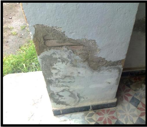
**Fig18.mur porteur en brique plein**
