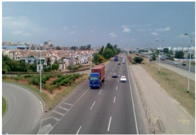
Figure 34 : vue sur l'autoroute est
