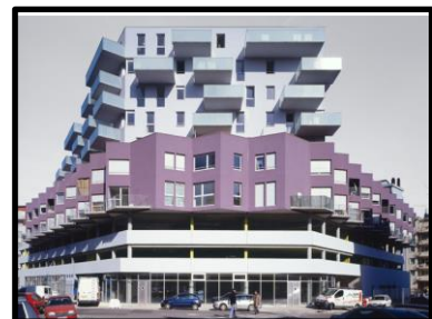
Figure 1: Immeuble à redents composé de plusieurs couches : garages superposés et logements aux financements variés, Grenoble
