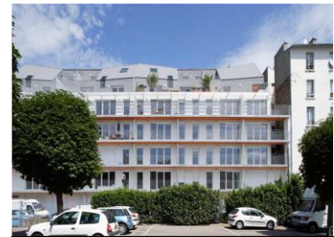
Figure 2: Façade de l'immeuble avec maisons sur le toit et maisons à l'intérieur de l'îlot, passage Chevalier, Saint-Denis (93).
