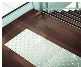
**Fig 5.87 : dalle podotactile**
