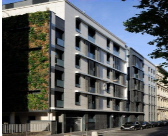
Figure 29 : un mur pignon Est transformé en jardin vertical,
