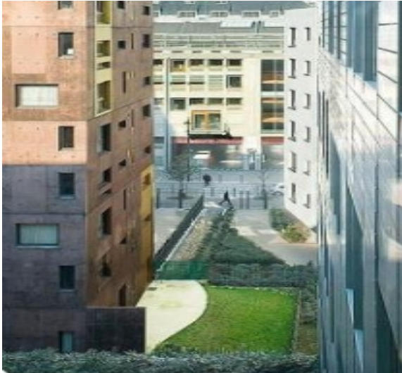
Figure 15 :Aucun bâtiment n'est mitoyen, source: le livre L'ilot ouvert Christian Portzamparc « paris rive gauche ».
