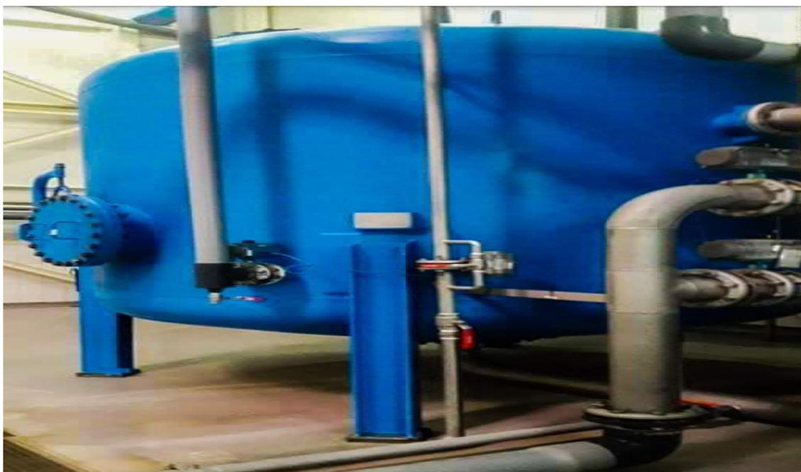
**Figure n°3** : Illustration d'une filtration à sable
