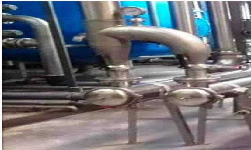
**Figure n°7 :** filtre à 5 $\mu$ m.
