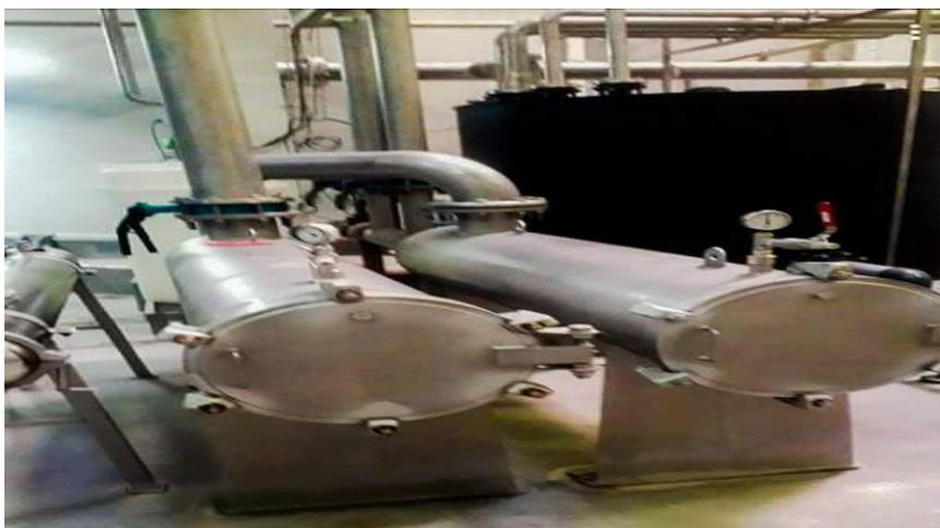
**Figure n°4** : illustration d'un filtre à cartouche
