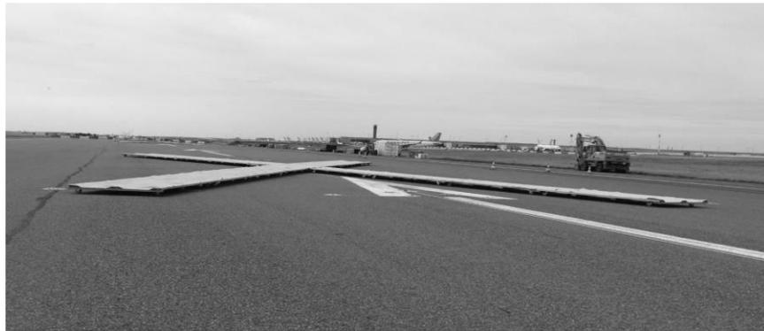
**Figure IV.B.2: disposition d'une croix mobile.**
