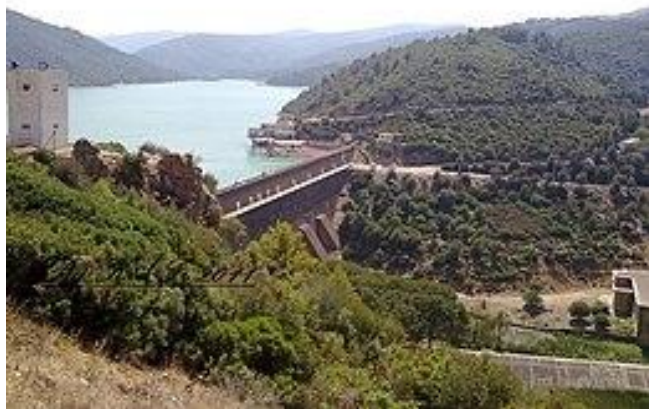
Fig. 4 : Barrage de Hamiz
