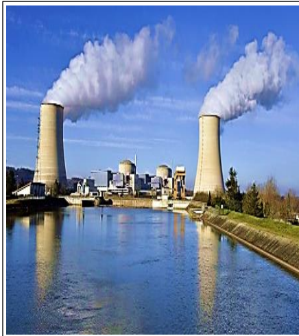
Figure 15 : les rejets d'eau chaude des centrales nucléaires dans le milieu aquatique
