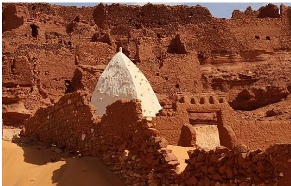
Figure7 :mausolé à ksar ighzar région de Gourara au milieu des constructions
