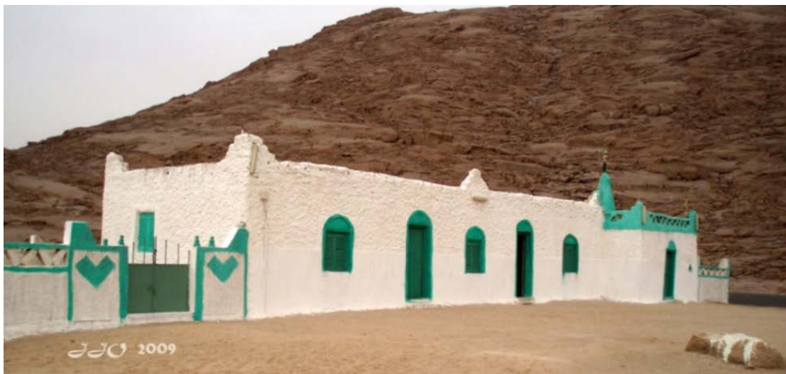
Figure 16 : la zaouïa de Moulay Sidi Lachen et le mausolée en 2009 Source : https://amis-pic-laperrine.forumpro.fr/t737-recherche
