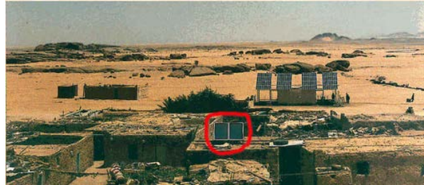
Figure 5 : système photovoltaïque sur foyers Source : http://echosolair.chez.com/partie-13-18-b.htm
