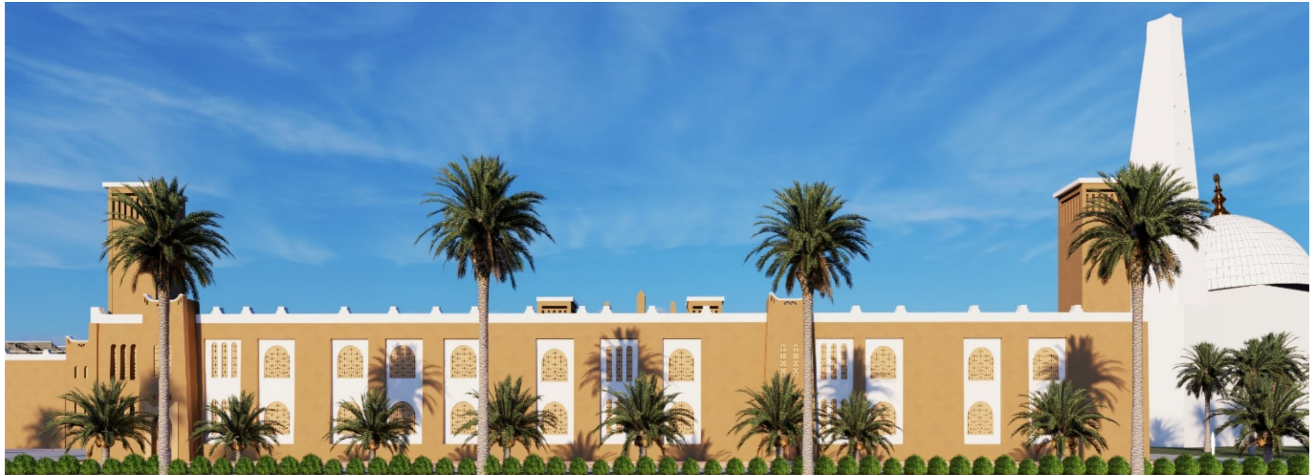
Figure : Façade latérale Sud de la maison d'hotes
