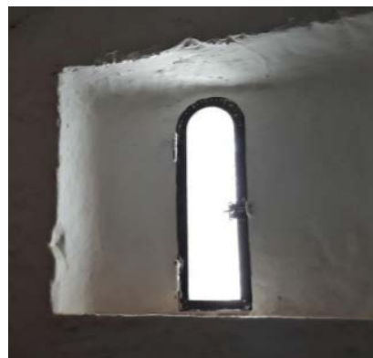
Figure50 : les fenêtres des chambres
