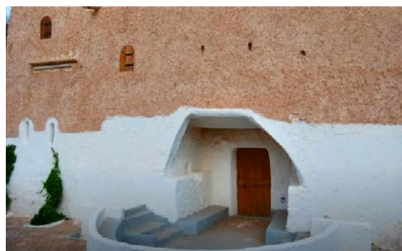
Figure 41 : façade d'une maison d'hotes Source : Mzab Tours
