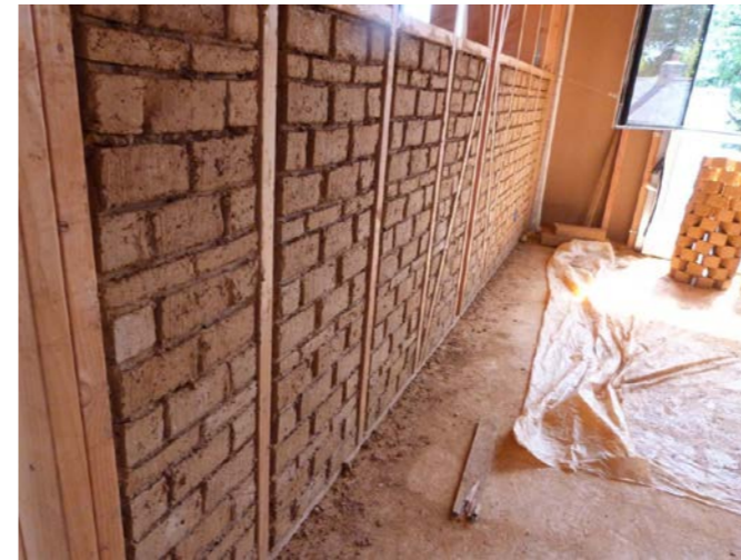
Figure 31 : construction d'un mur intérieur avec l'adobe Source : https://www.novabuild.fr/
