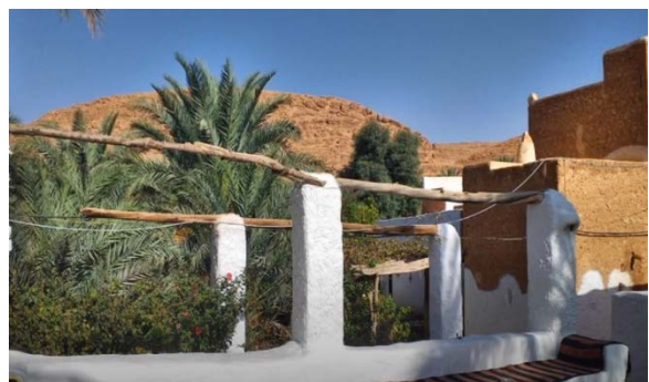
Figure 43 : murs extérieurs en pierre et recouvert de plâtre blanc
