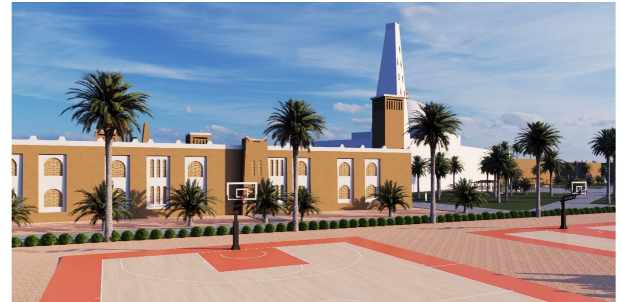
Figure 42 : Façade Sud un maximum de fenêtres. Fenêtres non ensoleillées par des moucharabieh.
