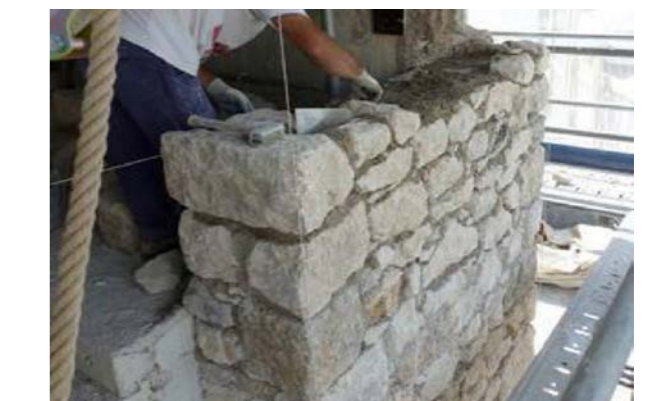
Figure 36 : Utiliser la chaux comme mortier Source : Batirama.com
