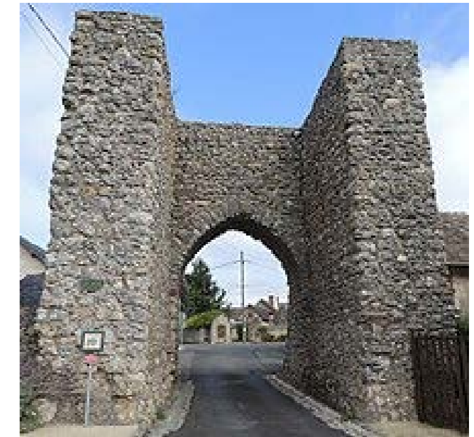
Figure 32 : Construction en moellons de pierre Source :
