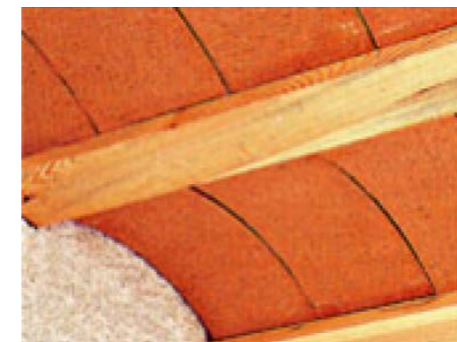
Figure 35 : utilisation du bois dans les planchers en voutains Source : Rue du chantier.com
