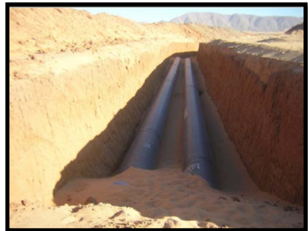
Figure 8 double conduite par refoulement
