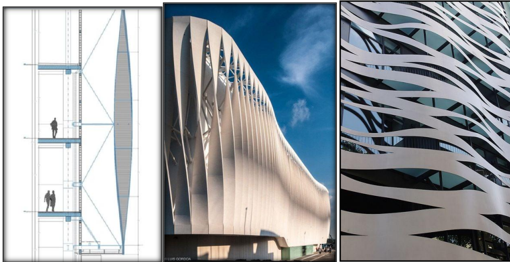
FIGURES102 : toiture ondulée.
