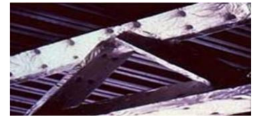
FIGURE 127: charpente protégée par laine minérale
