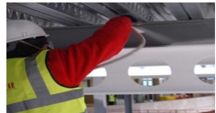
FIGURE 123: protection par flocage Source : site web : //www.google.dz/
