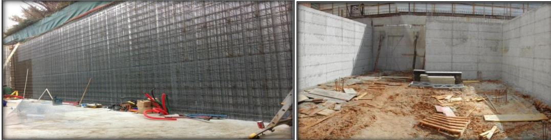
FIGURES 89: mur de soutènement.
