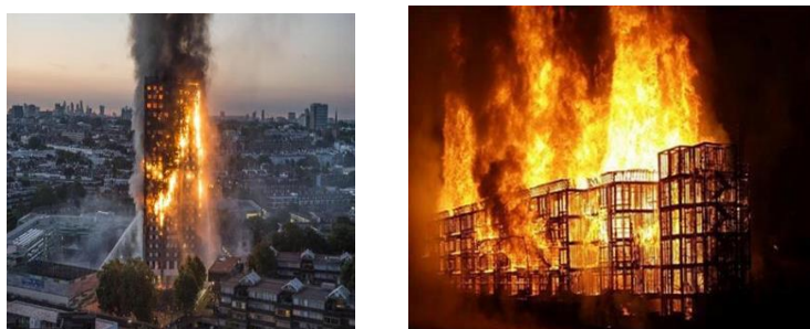
FIGURE 121 : effet de l'incendie Source : site web : //www.google. dz
