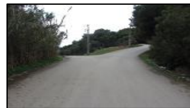
Figure 4-14 : la voie tertiaire. Source : auteur.
