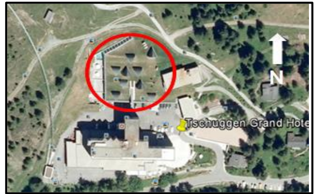
Figure 2-3 : la situation du centre Tschuggen Bergoase source : Tschuggen Bergase http://tschuggen.ch/fr/spa
