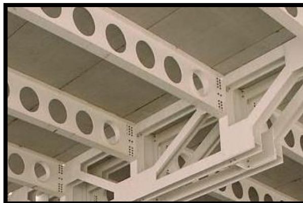
Figure 0-20 : poutres alvéolés. Source : Wikipédia.
