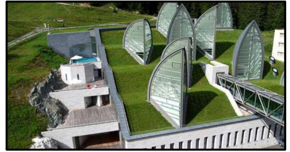
Figure 2-17 : la toiture végétalisée source : http://tschuggen.ch/fr/spa
