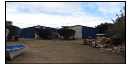
Figure 4-16 : hangar de fabrication de bateaux Source : auteur.
