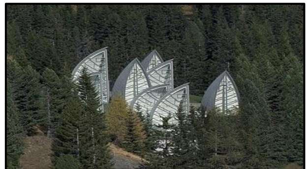
Figure 2-16 : l'environnement immédiat du Centre source : http://tschuggen.ch/fr/spa
