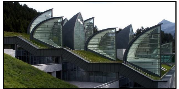
Figure 2-19 : les puits de lumière avec le double vitrage source : Centre de bien-être Bergoase. Mario Botta. Arosa (Suisse). 2006
