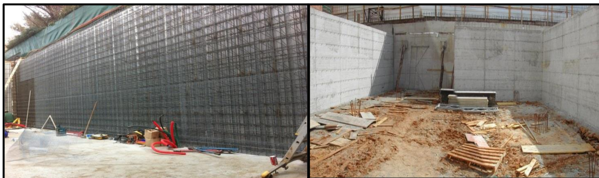
Figure 0-18 : mur de soutènement. Source : Wikipédia.
