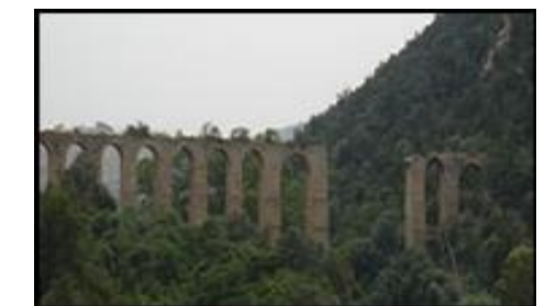
Figure 4-25 : les aqueducs Source : auteur.
