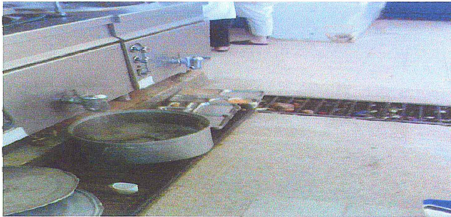
Figure N°15 : Débris de denrées sur les filtres d'évacuation
