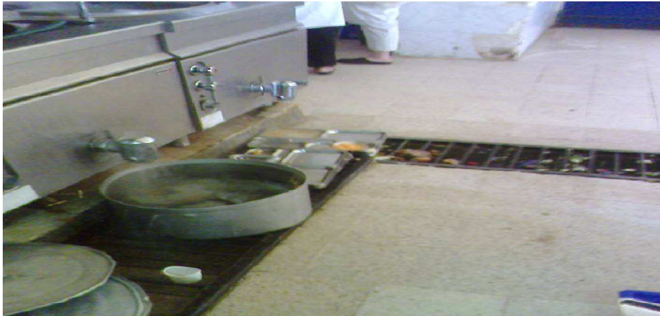
Figure N°15 : Débris de denrées sur les filtres d'évacuation
