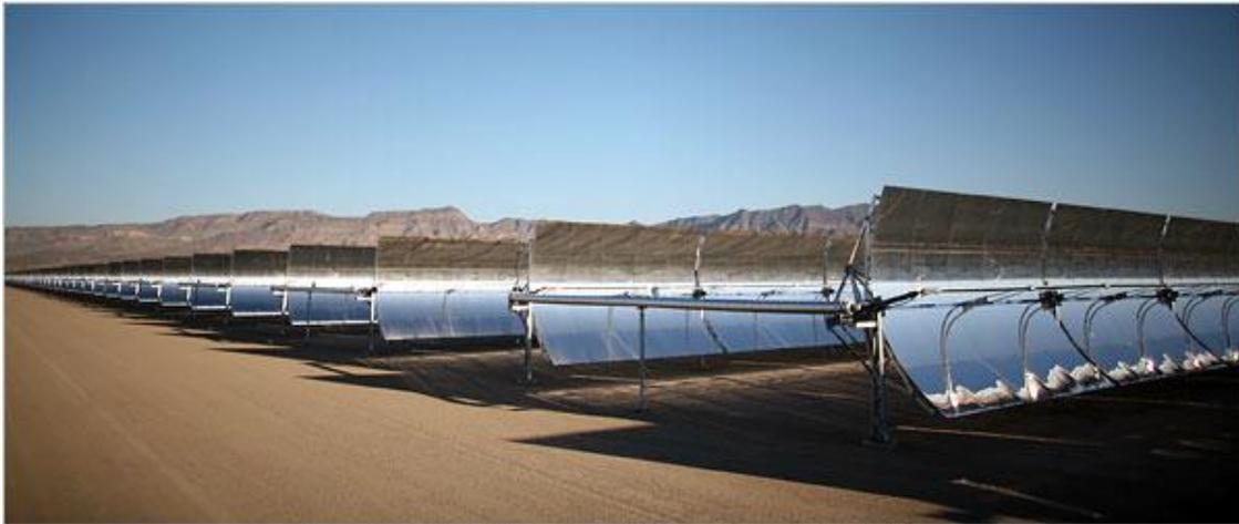
Fig. 1.4. Concentrateurs cylindro-parabolique dans la centrale de Nevada [<http://www.nytimes.com>].
