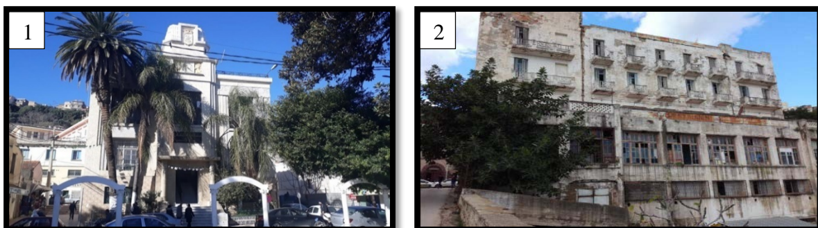
Figure 65 : Équipements coloniales (APC, Hôtel Beau Rivage) donnant sur la RN 24.
