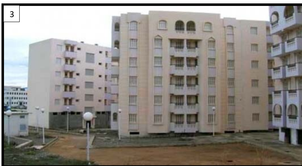
3 Vue aérienne de la nouvelle extension à Meftah- Blida une des villes intérieures Source : http://www.algerie-immobilier.com
