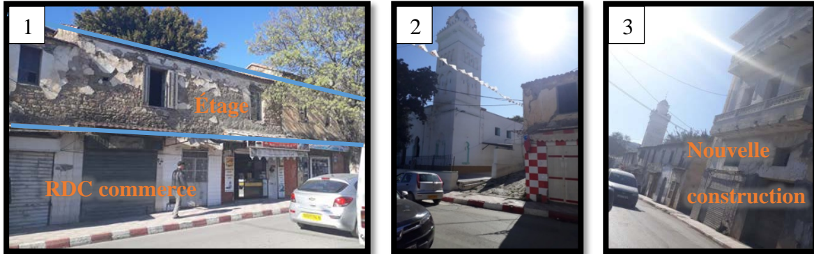
Figure 63 : Construction du Casbah donnant sur la RN 24.
