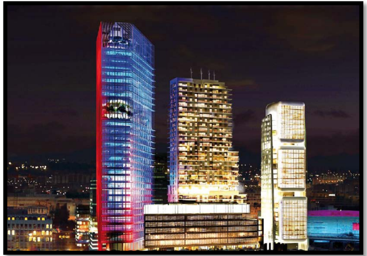
Figure 41 : vue sur les trois tours du Marseille
