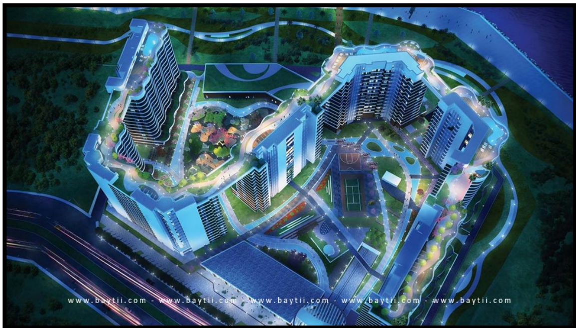
Figure 34 : Vue sur les lumières du projet dans la nuit
