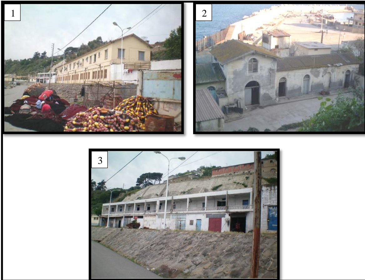
Figure 70 : Photos des constructions sur la partie port.
