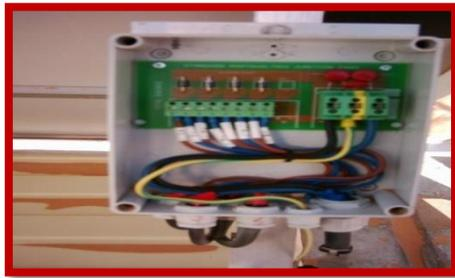
Figure I.35: Le boîtier de raccordements
