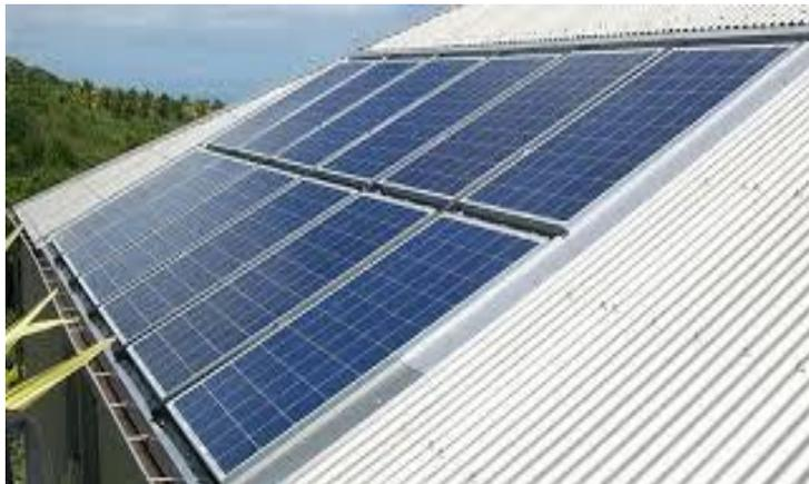
Il faudra veiller que l'espace entre l'arrière des modules et la toiture soit suffisant afin de faciliter le flux d'air et donc le refroidissement.
