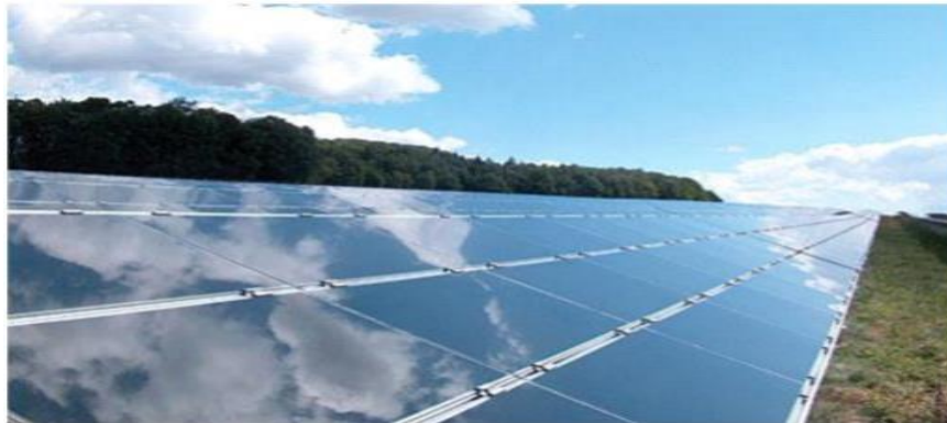
Figure 7 modules verre-verre au Telluride de Cadmium, efficacité de 9 à 11%. [12]
