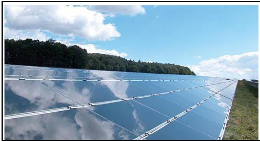
Figure I. 2. Modules verre-verre au Telluride de Cadmium, efficacité de 9 à 11%.
