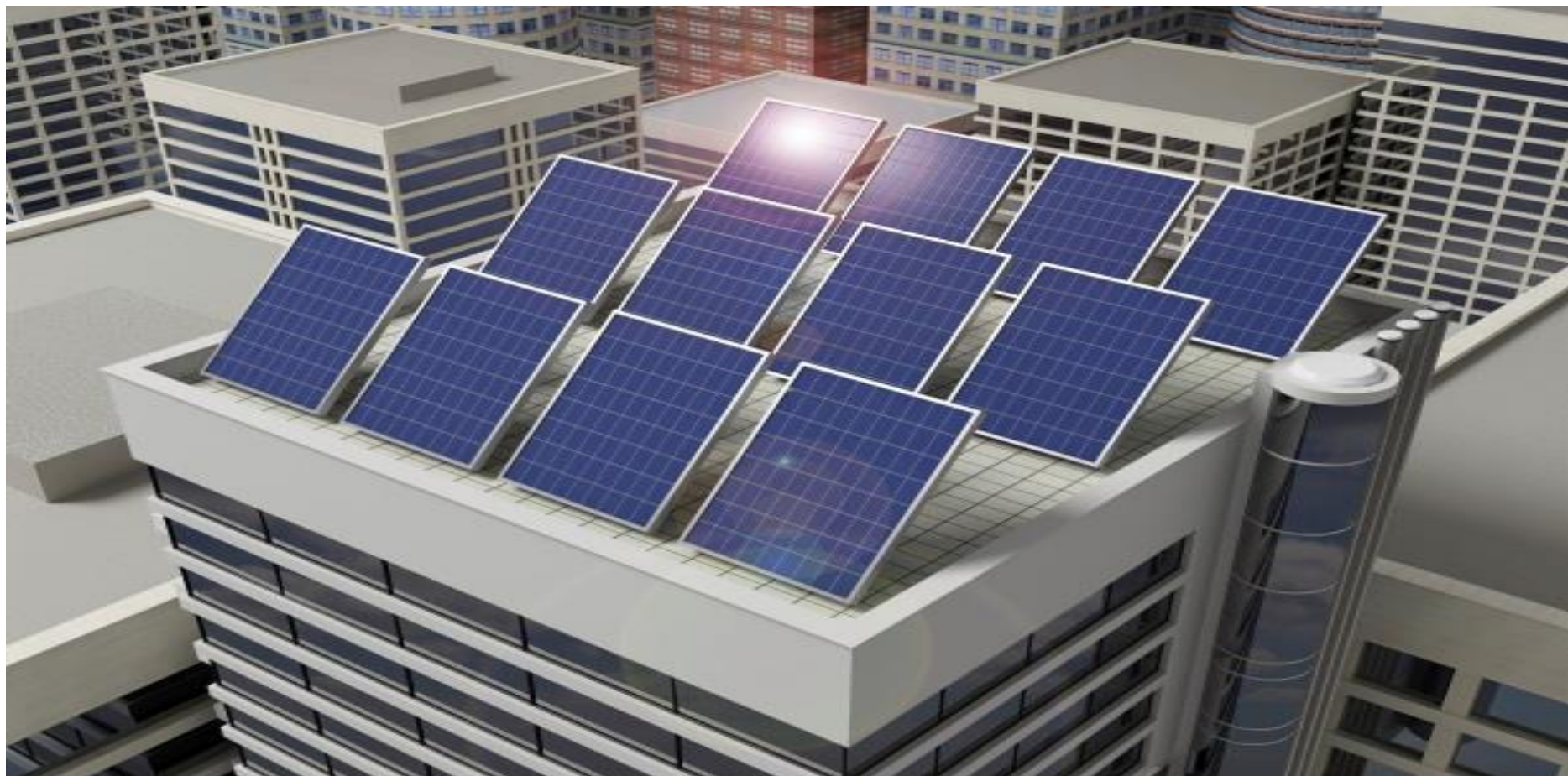
Figure: panneaux solaire sur toiture.
