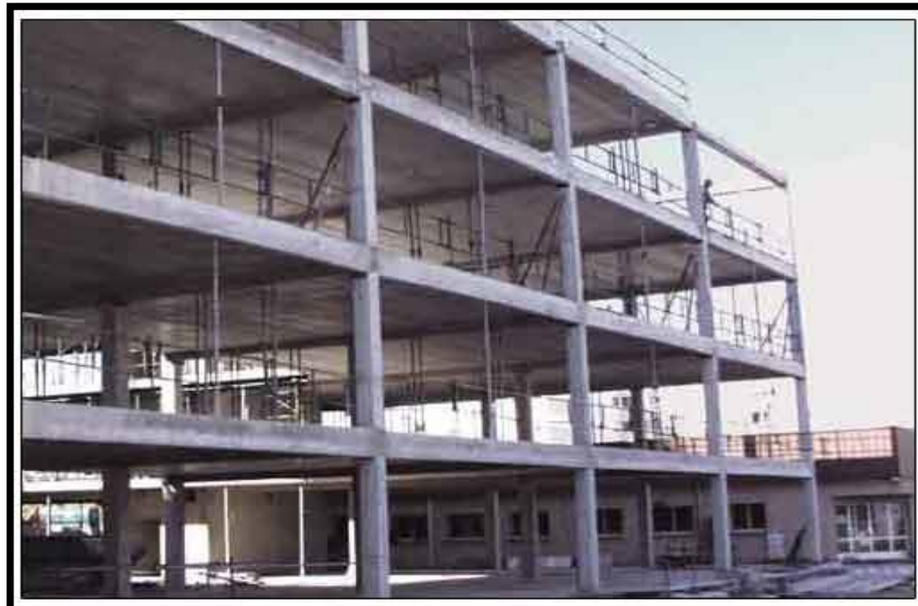
Figure : le système constructif poteaux poutre en béton armé
