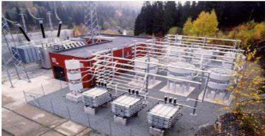
**Figure II-13** Exemple d'un SVC\*
