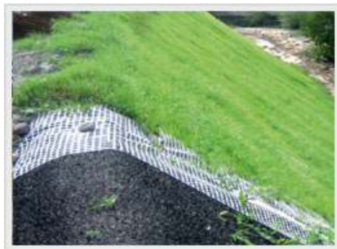
Figure 39.Utilisation contre l'érosion.
