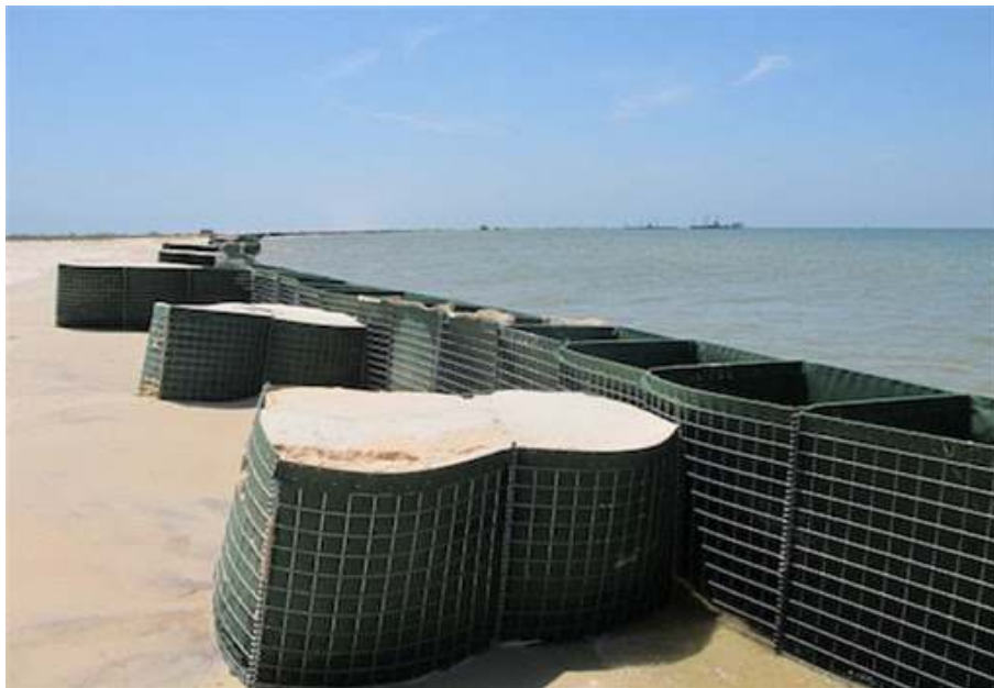
Figure 42. Utilisation pour Étanchéité
