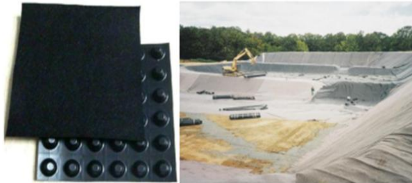
Figure II.11 : Géo-membrane à gauche leur forme, et à droite leur mise en place [9].
