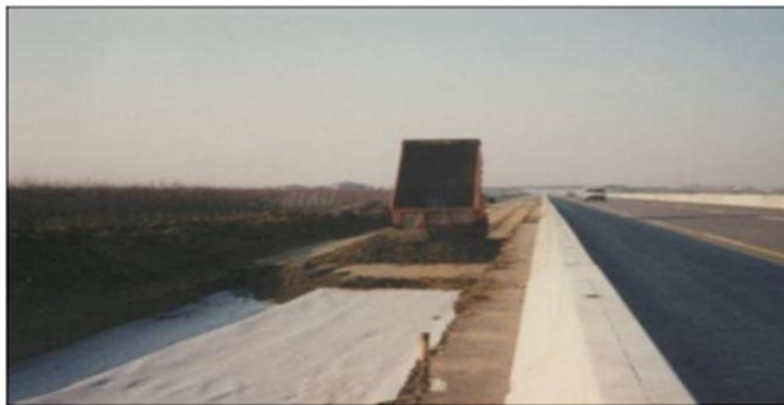
Figure II.18 : Un géo-synthétique dans une construction routière [9].
