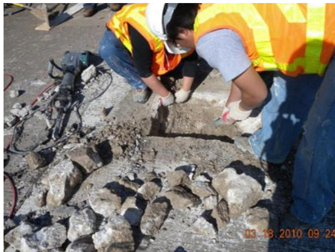
Figure I.30 : Enlever le béton détérioré [6].
