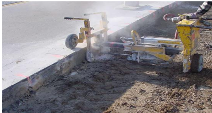
Figure I.25 : Perçage de trous au joint longitudinal [6].
