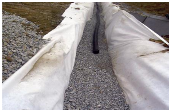
Figure II.16 : utilisation pour drainage [10].
