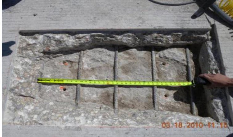
Figure I.31 : Nettoyez les surfaces de réparation [6].
