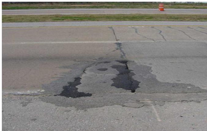
Figure I.23 : Réparation complète des perforations dans CRCP [6].
