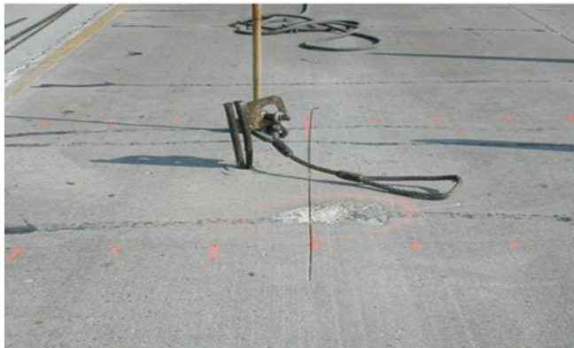
Figure I.24 : Dalle prête à être soulevée [6].
