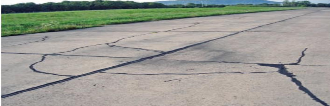
Figure I.13 : Pompage identifié par les dépôts de fines [5].
