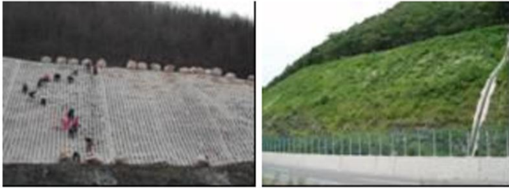
Figure II.24 : à gauche contrôle d'érosion sur pente, à droite travaux achevés [9].
