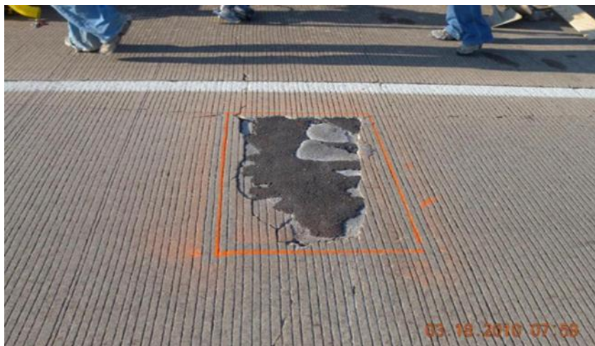
Figure I.28 : Identifiez les limites de réparation [6].
