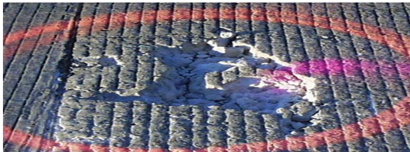
Figure I.22 : Effritement profond [6].
