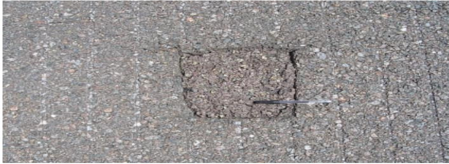
Figure I.19: Réparation ponctuelle[5].
