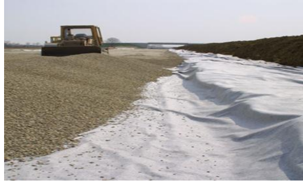
Figure II.12: géotextile de séparation [10].
