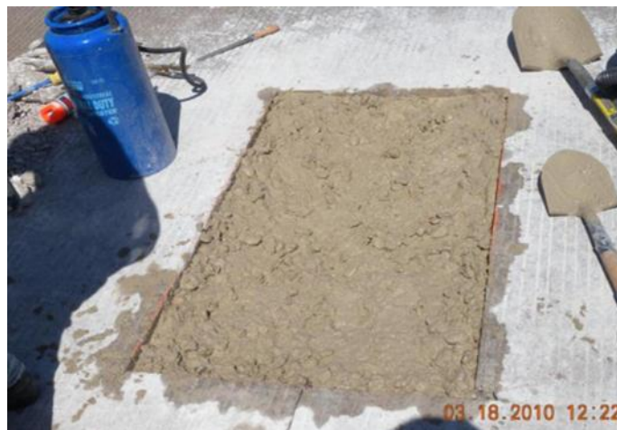
Figure I.32 : Placez les matériaux de réparation [6].
