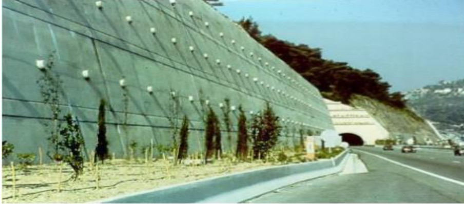
Figure 1.10 : Exemple de mur cloué
