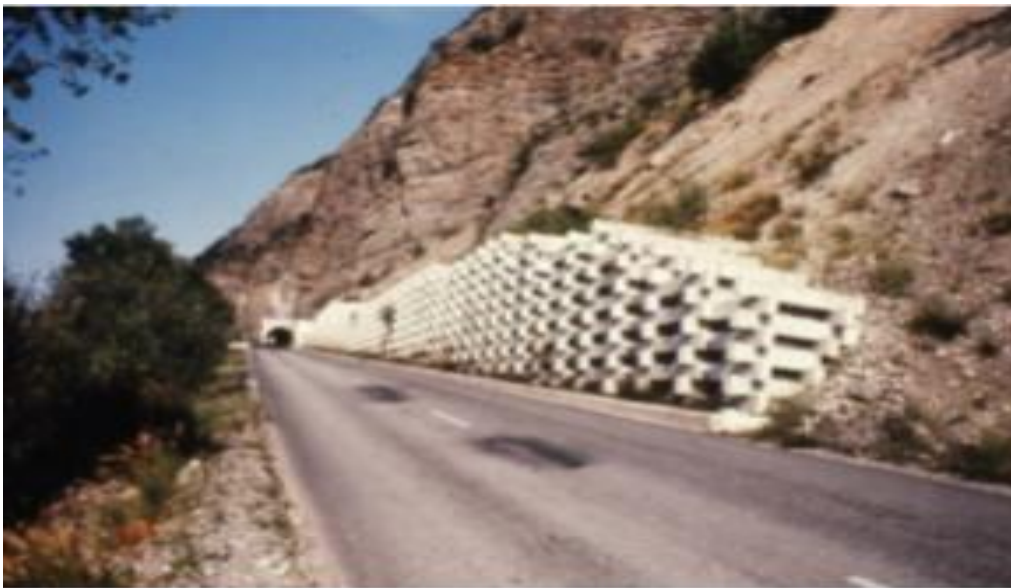
Figure 1.3 : Mur en éléments préfabriqués en béton empilés.
