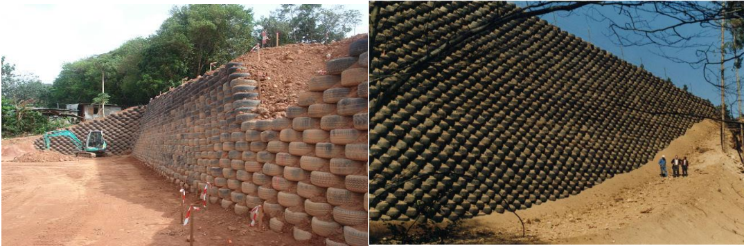
Figure 1.14 : Mur en pneu sol
