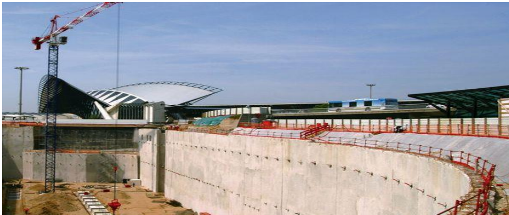
Figure 1.6. mur en parois moulées.
