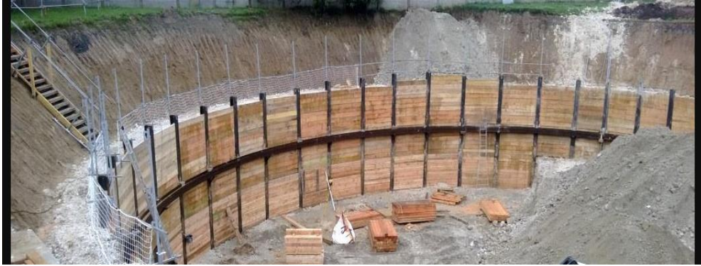
Figure 1.8 : Les murs en parois berlinoises
