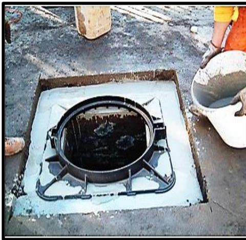
**Figure I.3 :** Utiliser le mortier pour remplir les conduites
