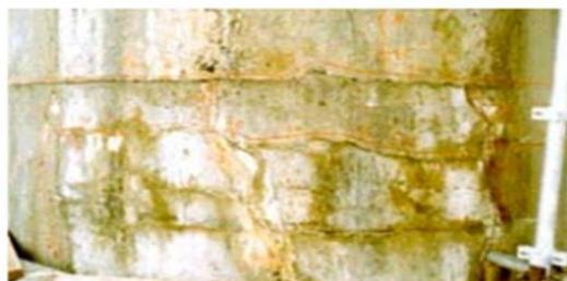
Figure 1.9 Attaque interne du béton
