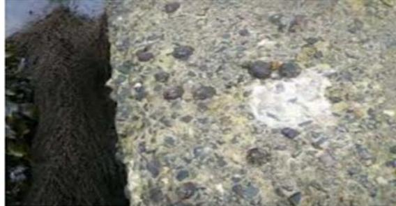
Figure 1.8 Attaque externe du béton, par des chlorures et attaque sulfatique.
