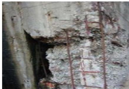
Figure 1.11 Corrosion par carbonatation
