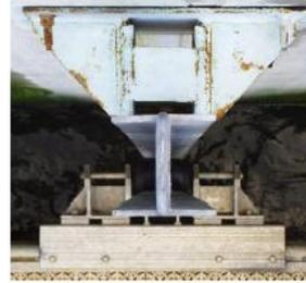
Figures 3.68 et 3.69 Schéma et prise de vue d'un guidage sur poutrelle HEA 140
