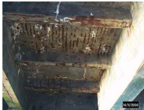
Figure 1.7 Effet de corrosion
