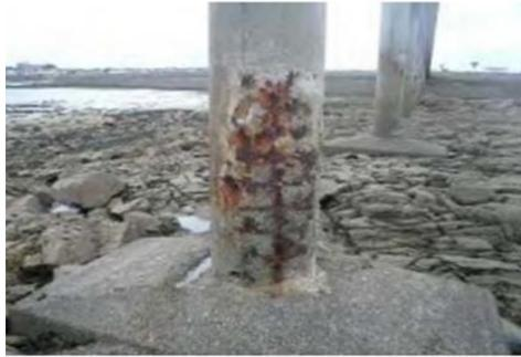
Figure 1.10 Corrosion des armatures, pénétration des chlorures.
