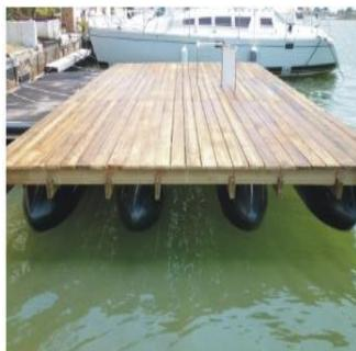
Figure 3.22 Plancher avec flotteurs hydrodynamique
