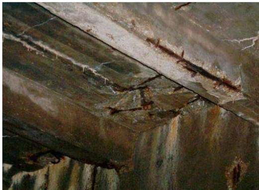
Figure 1.6 Fissuration de béton
