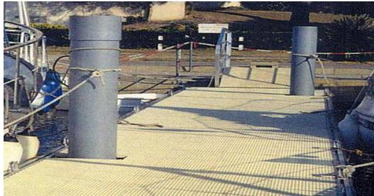
Figure 3.59 appontement stabilisé par des pieux
