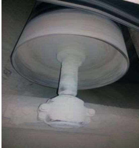
Figure (1.9) : Tambours de contrainte.(cimenterie de MEFTAH)
