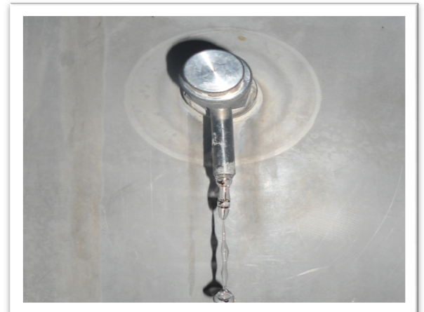
Figure N° 03 : Site de prélèvement de l'eau de process (eau traité) (original)
