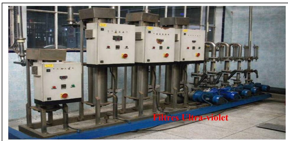
Pompes d'envoi d'eau de process vers les lignes de production + filtres UV
