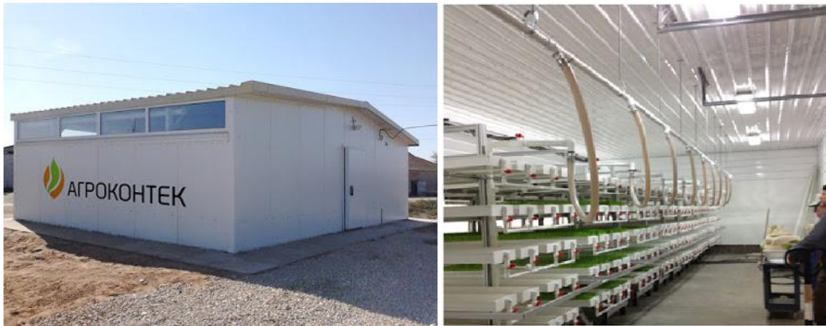
Figure 8. Hangar hydroponique vue de l'extérieur (A) et de l'intérieur (B) (Hacini 2016).
