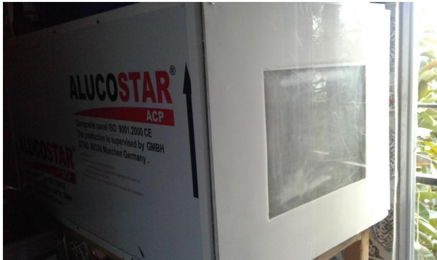
Figure 9: Partie extérieure de la chambre hydroponique
