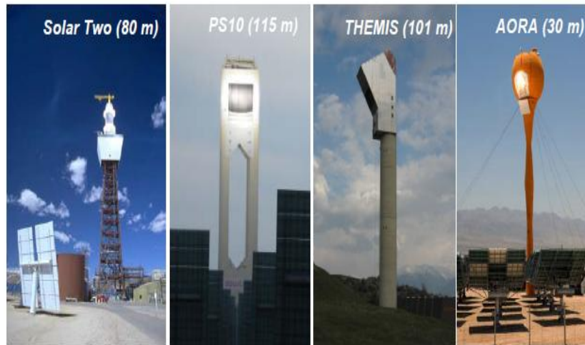
Figure 1.14 : Exemples de tours de centrales solaires
