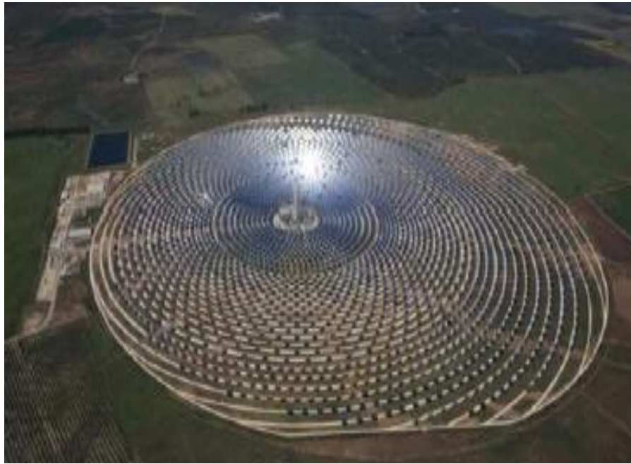
Figure 1.8 : Centrale Gemasolar (Espagne) [58]
