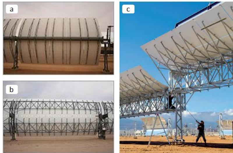
**Figure 1.8** : Exemples de structures métalliques : a. LS-2, b. LS-3, c. EuroTrough, [47]
