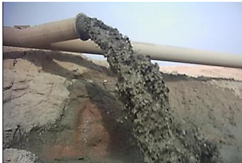
Figure 1. 13: Rejet de la vase lors de l'opération de dragage de 2005-2006
