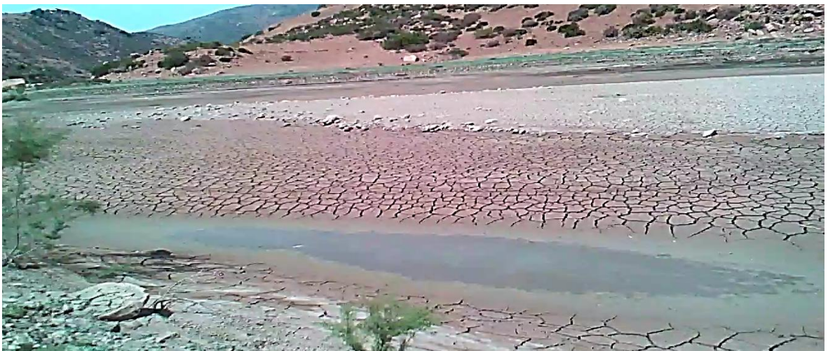
Figure 2.15 : Dépôt de vase à l'embouchure de la retenue du barrage de Sidi Yacoub (Photo: S. Benkaci, Aout 2017).
