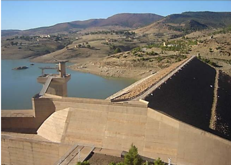
Figure 2. 19: Retenue du barrage DeurDeur [75] .
