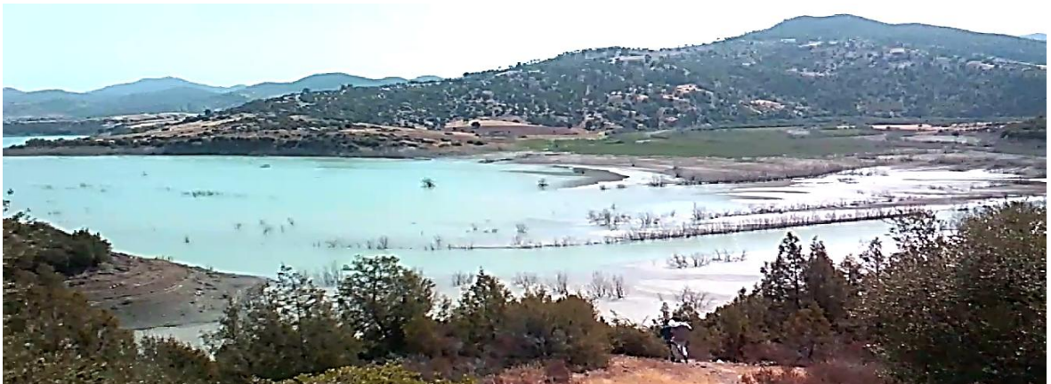
Figure 2.17: Dépôt de vase à l'embouchure du barrage d'oued Fodda (Photo : S. Benkaci, Aout 2017).
