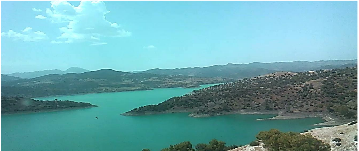
Figure 2.16 : Retenue du barrage oued Fodda (Photo : S. Benkaci, Aout2017)
