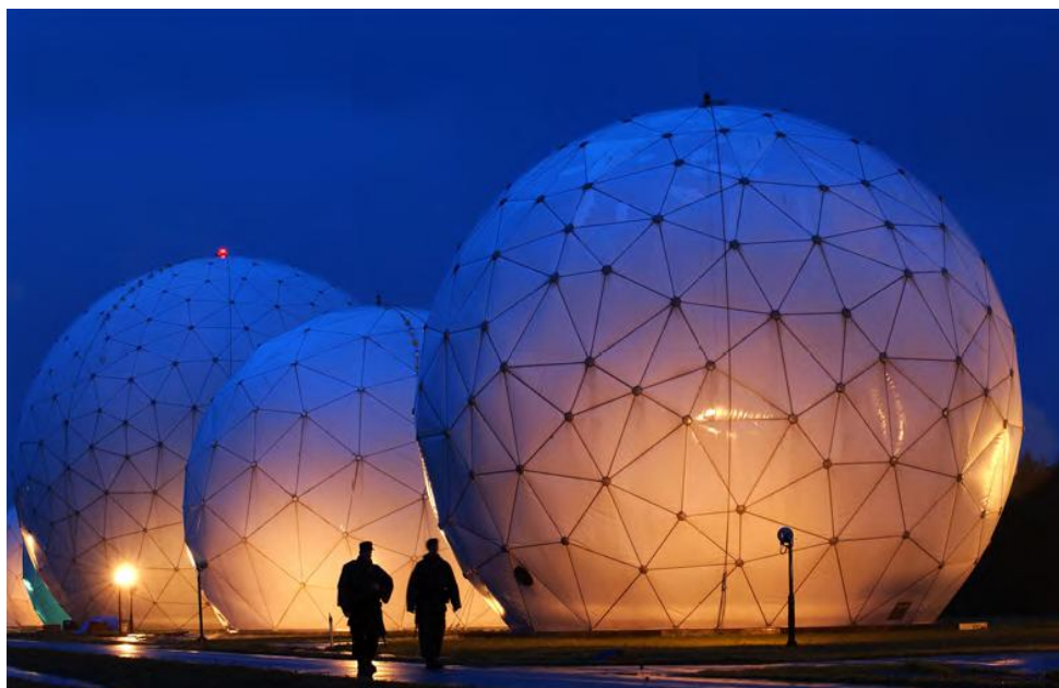
Figure 1.15 : Radômes rigides au Centre des Opérations de Cryptologie, Misawa, Japon [89]
