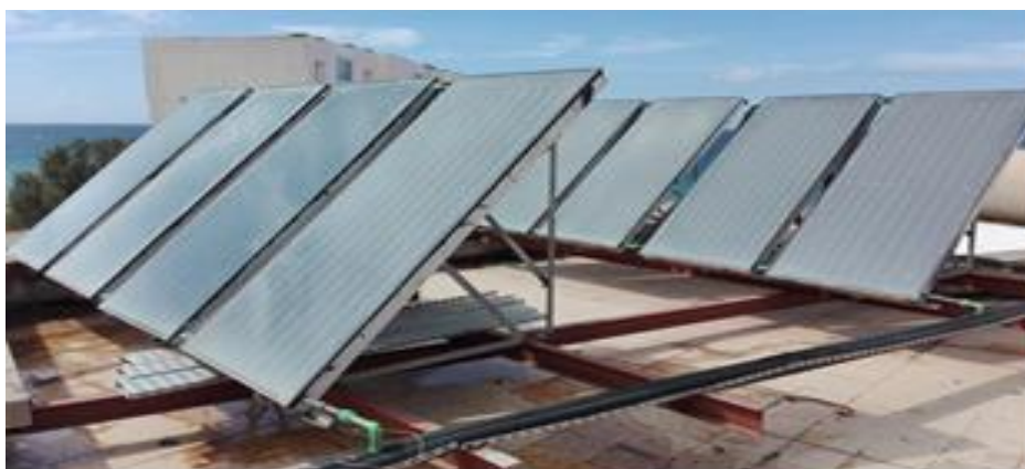
Figure 5.13 : Champ des capteurs solaires plans
