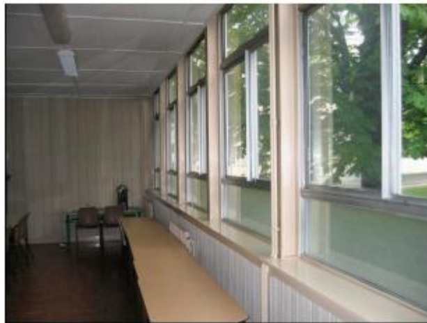
Figure1. 29 : Structure intérieure du bloc après réhabilitation avec MCPs 173
