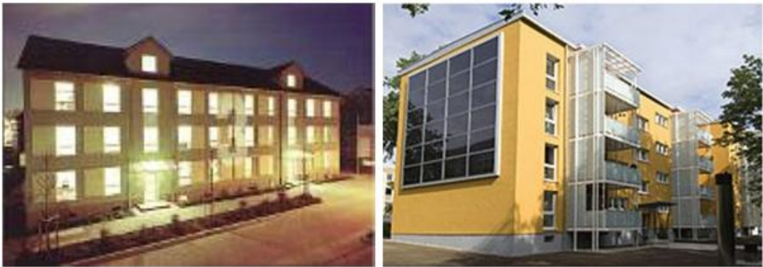
Figure1. 27 : Image du bâtiment réhabilité; à gauche : avant l'opération, à droite : après la réhabilitation 35 .
