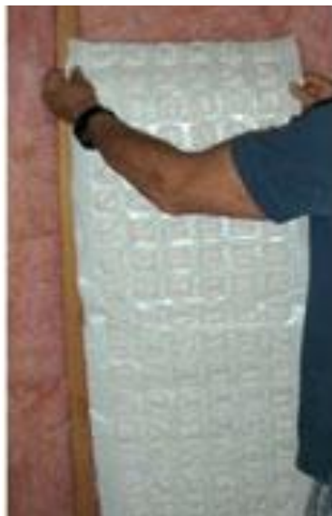
Figure1. 24 : mise en place du bio-MCP sur les murs de la maison Trek-hauss 35
