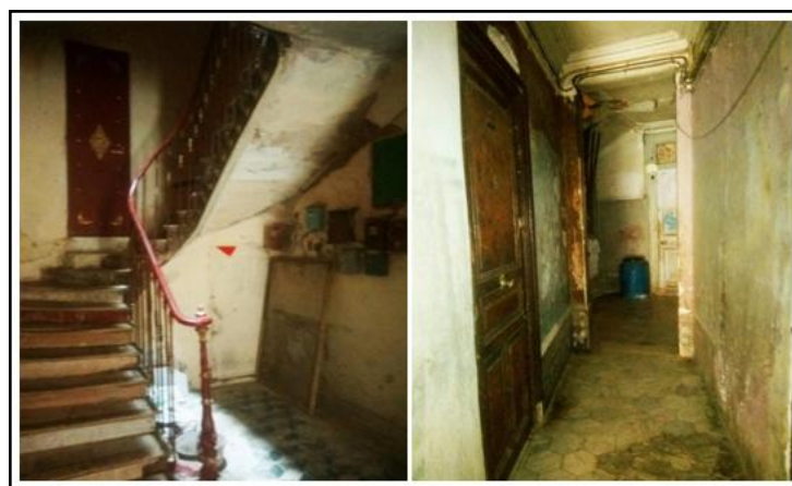
Figure.III. 23. Espaces communs mal entretenus dans des blocs ex : (à droite bloc N°5 /ilot N°0 6 et à gauche bloc N°7/ilot N°13 mal entretenus ) Source. Auteurs.
