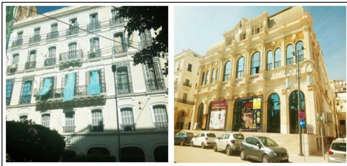
Figure.III. 16. A droite le Bâtiment N1/ilot N°18, à gauche le Théâtre National d'Alger, rue Abane Ramdane Source. Auteurs.
