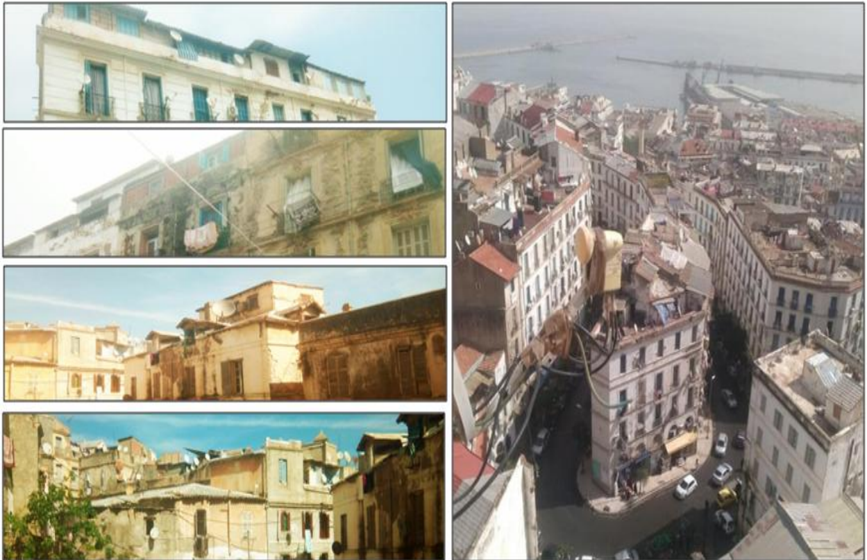
Figure.III. 12. Terrasses accessibles occupées par des constructions illicites. Vue sur la rue Debbih Cherif, coté ouest de la zone d'étude Source. Auteurs.
